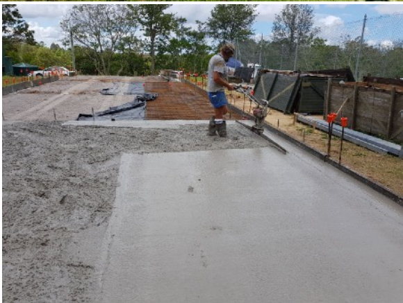
Pouring the slab
